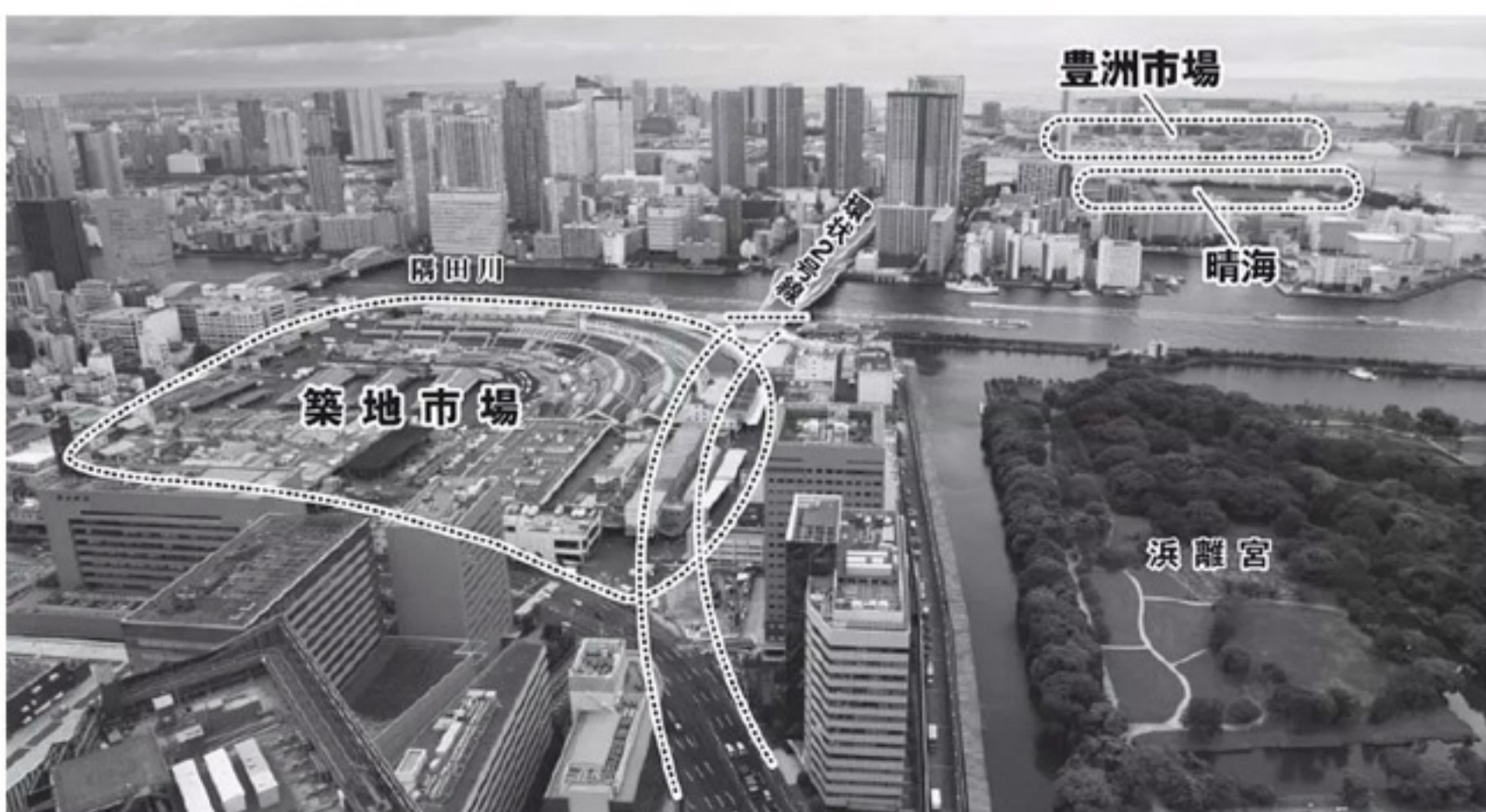
写真左側の築地市場から、高層ビルの奥に見える豊洲に市場が移る。その中間にオリンピックの選手村が建設される晴海があり、それらを結ぶ環状2号線が急ピッチで建設中だ。今、2号線は築地で止まっている。早く壊して道路をつなげたいのだろう
